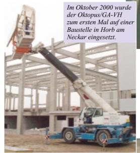
men diese Systemkombination derzeit ein. Der Compact Truck wird dabei gleich als zwei in einem eingesetzt. Zum einen beschickt er als 40-Tonnen-Kran den Dachbereich, zum anderen dient er für den Wandfassadenbau als Arbeitsbühne.
