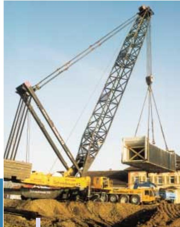
Schmidbauer's Gottwald AK 850/1100 hier mit 41 Meter Hauptausleger und 210 Tonnen Drehballast. Der Kran hebt bei 20 Meter Ausladung einen 235 Tonnen schweren Betontunnel beim Bahnhof Salem innerhalb von zwei Stunden ein.
