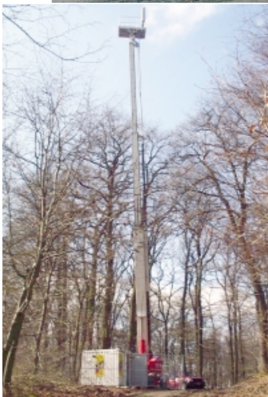
Auf dem Weg zum Einsatzort. Die TKD 3100 DSA als mobiler Funkturn
