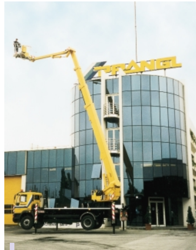
Rund 200 Kranen und 900 Arbeitsbühnen zählt Prangl sein Eigen.
