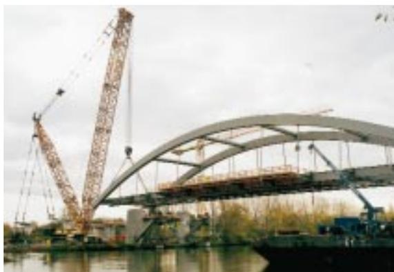
ende auf zweiachsige Selbstfahrer setzen. Für die schweren Geräte wurde der Untergrund auf 50 t/qm verdichtet.
