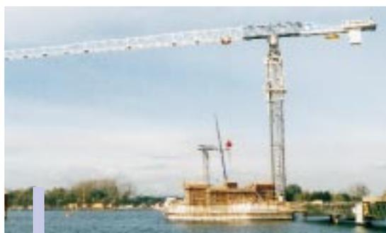
Die Befestigung des TT 331 auf deutscher Seite, der im Fluß auf einen Pfeiler aufgestellt wurde, erfolgt mittels einer Spezial-Felsplatte.
