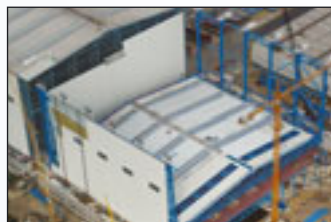
Am Boden wird das Dach vormontiert...
