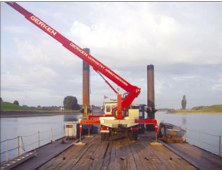
Zur Inspektion der im Jahre 1933 erbauten Hubbrücke über das Hafenbecken des Nordhafens in Duisburg-Walsum setzte Gerken auf die „schwimmende Lösung“, sodass eine Prüfung vom Wasser aus möglich war.
