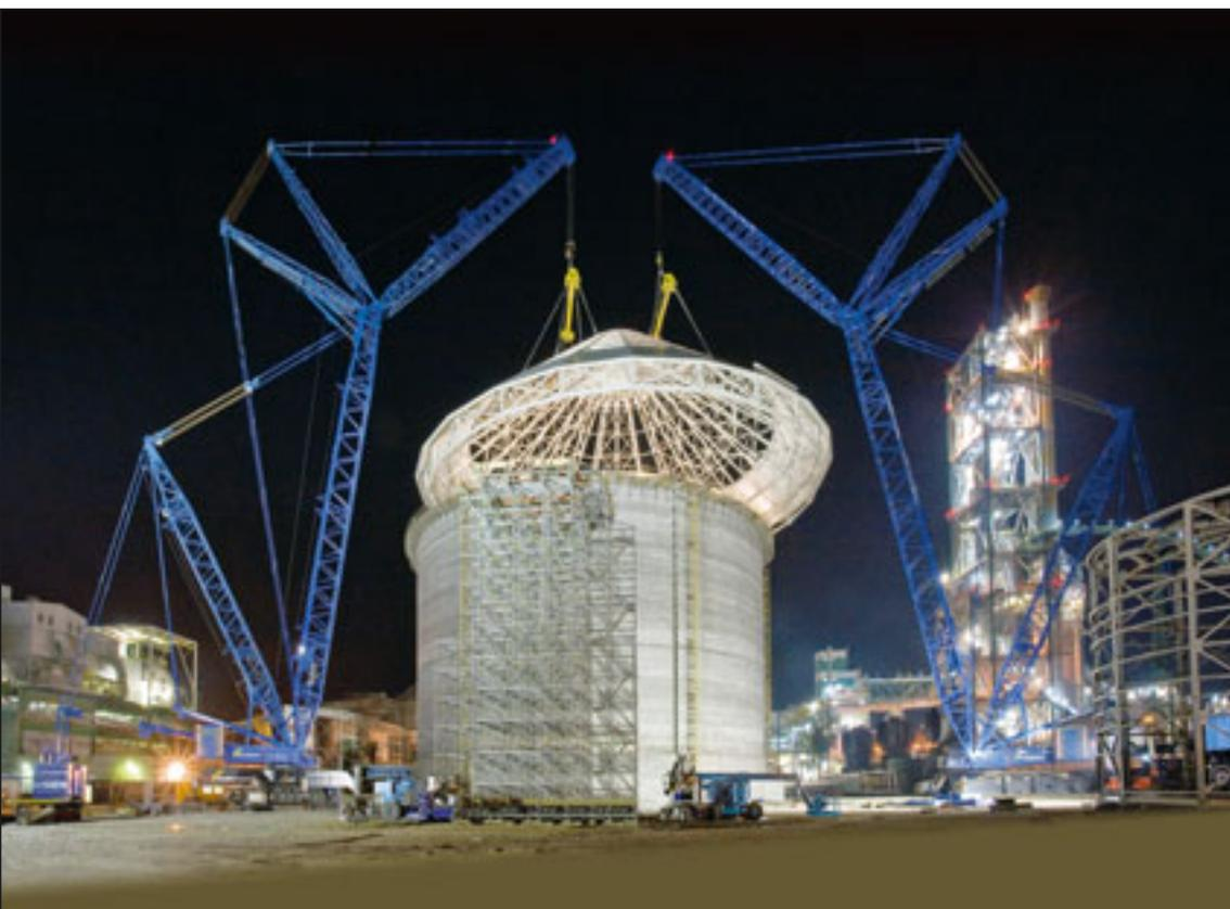
Ein Tandemeinsatz eines LG 1750 und einer LR 1750 von Felbermayr in Polen. Ein Silodach musste in einem Zementwerk auf 37 Meter Höhe eingehoben werden. Nach vier Stunden war vorbei, wofür zuvor einige Monate Vorbereitungszeit notwendig waren.
