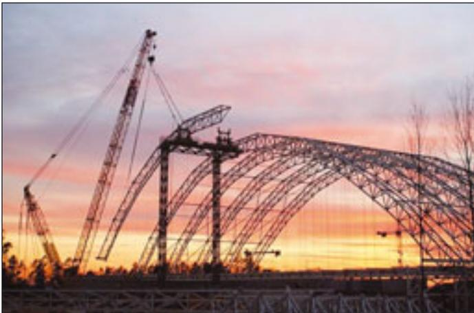
Für die Montage einer Überdeckung mit einer Spannweite von 150 Meter der Sondermülldeponie im schweizerischen Bonfol kam ein CC2500-1 mit 96 Meter SLLSL zum Einsatz. Die Bogenhälften hatten ein Gewicht von bis zu 86 Tonnen und sind teilweise in Tandemhub mit einem AC500-1 eingehoben worden. Die Überdeckung soll den umweltgerechten Abbau der Deponie gewährleisten.
