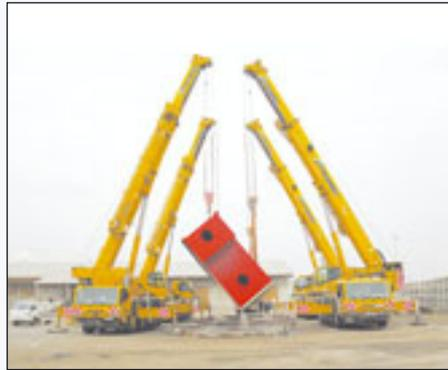
sungen nur noch liegend auf öffentlichen Straßen manövriert werden. Die Transportbreite betrug bei diesem Stahlelement 4,40 Meter. Um Beschädigungen an den Kanten zu vermeiden, musste dieses Torelement mit vier Teleskopkranen gleichzeitig
