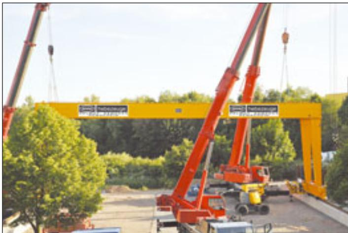
Auf eine Spannweite von 28,5 Metern mit einer Tragkraft von 32 Tonnen kommt der Portalkran, die die Helmut Kempkes GmbH, Kuli Hebezeuge nun ausgeliefert hat. Der Elektroseilzug des Krans ist in FEM 3m eingestuft und hat ein elektronisches Lastspektrometer. Hiermit lassen sich neben dem
