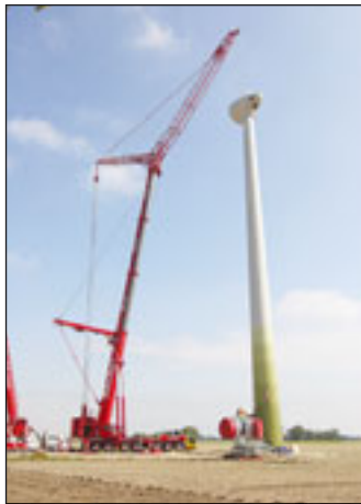
Ein Grove GMK7450 mit Mega-Wing-Lift errichtet eine 113 Meter hohe Windturbine in Reinsbüttel
