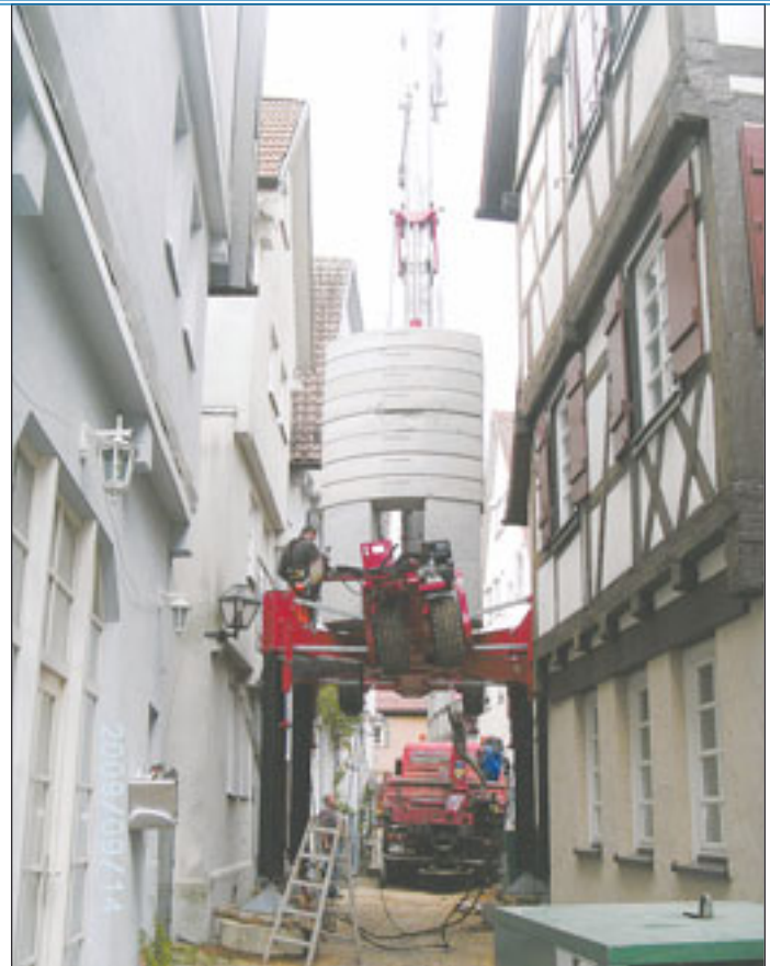
Einsatz in engen Gassen: Der Gelco 2120 TTBE
