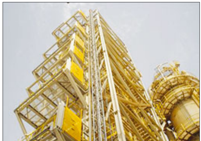
Safi: ATEX-geschützter Permanentaufzug für die Gasförderung
