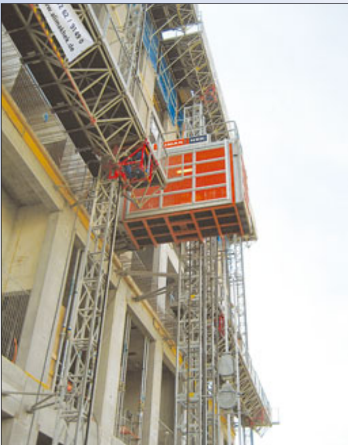
Zwei Scando-Bauaufzüge komplettieren den Mastenwald
