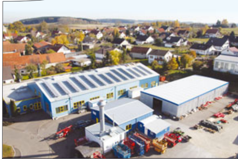
Sitz von PB Liftechnik in Oberbechingen
