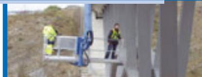
Gleich zwei Brücken hatte ein Ingenieurbüro an der Autobahn A71 zu inspizieren. System-Lift-Partner Lindig aus Eisenach setzte dabei auf eine Wumag WT 450, denn Zugang und Zufahrt waren nicht einfach. Beim ersten Einsatz ging es von der Brücke nach unten zur Inspektion, bei der zweiten Brücke ging es von unten heran, da war die seitliche Reichweite von über 25 Meter gefragt.
