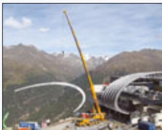
einsetzende Schneefall mit etwa 30 Zentimeter Neuschnee. Auf 2.174 Metern stellte Prangl das Stahlverkleidungsskelett der Mittelstation auf. Der eingesetzte LTM 1095-5.1 aus der Tiroler Niederlassung hob dabei Stahlteile mit Einzelgewichten von bis zu elf Tonnen.
