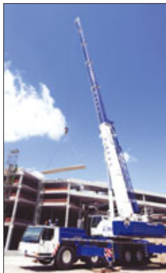
Liebherr LTM 1220-5.2 bei der Kranarbeit
