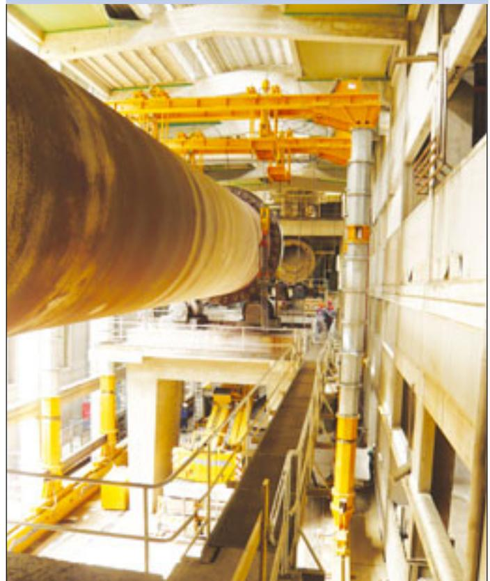
Enge, soweit das Auge reicht: Prangl demontiert einen Drehrohrföfen mit alternativer Hebetchnik
