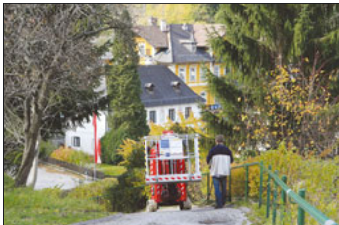
Auch steile Wege sind mit Raupenbühnen, wie diese Bluelift, machbar
