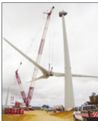
1.000 Windkraftanlage in Portugal feiern. Zum Einsatz kam der **Liebherr**-Raupenkran LR 1400/2 des portugiesischen Kranspezialisten Montalgrua. Um das 63 Tonnen schwere Maschinenhaus bei einer Hakenhöhe von 85 Metern auf den Turm zu montieren, wurde der 400-Tonner mit 91 Meter Hauptausleger, Derrick und 10,7 Meter feste Spitze aufgebaut.
