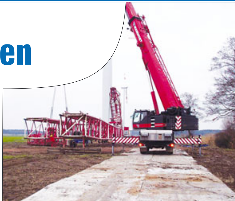
Um auf dem weichen Untergrund sicher zum Windrad zu kommen und die Kranarbeiten ausführen zu können, kamen hier so genannte Trax-Panels von TPA zum Einsatz
