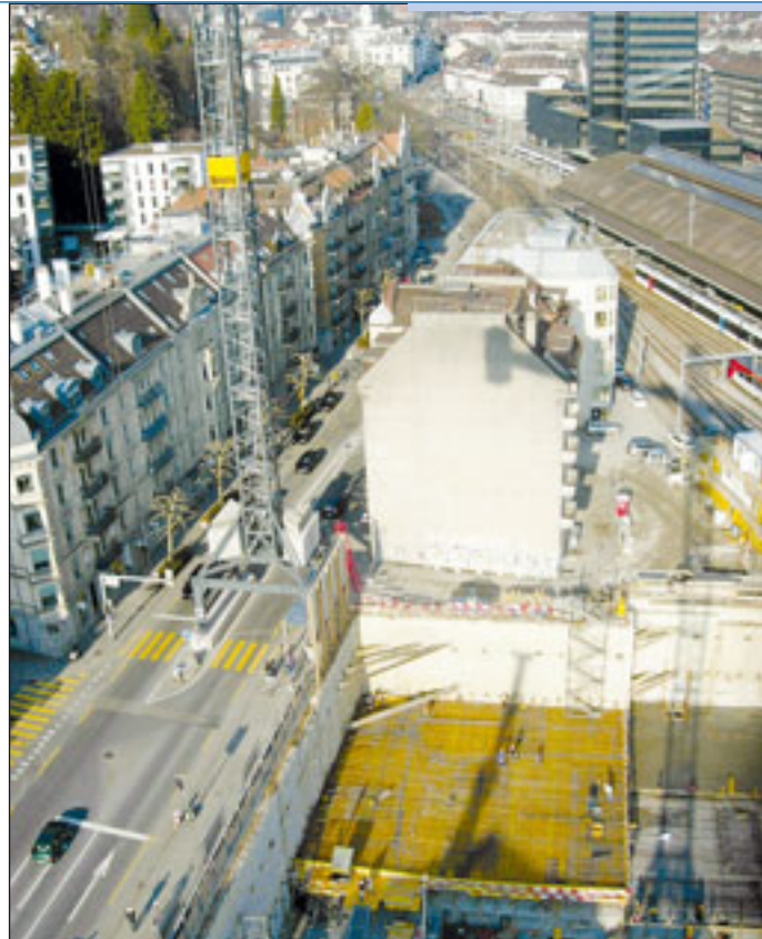
Zwei Peiner SK 415 auf Portal und einen WT200 von Kaufmann Kranservice auf einer Großbaustelle in St. Gallen
