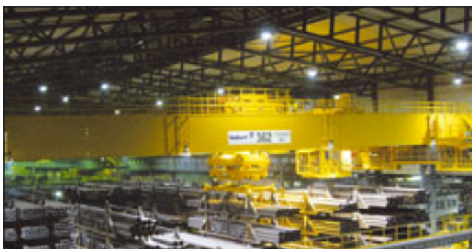
Lösungen für Automatikkrane bietet Vollert Anlagenbau
