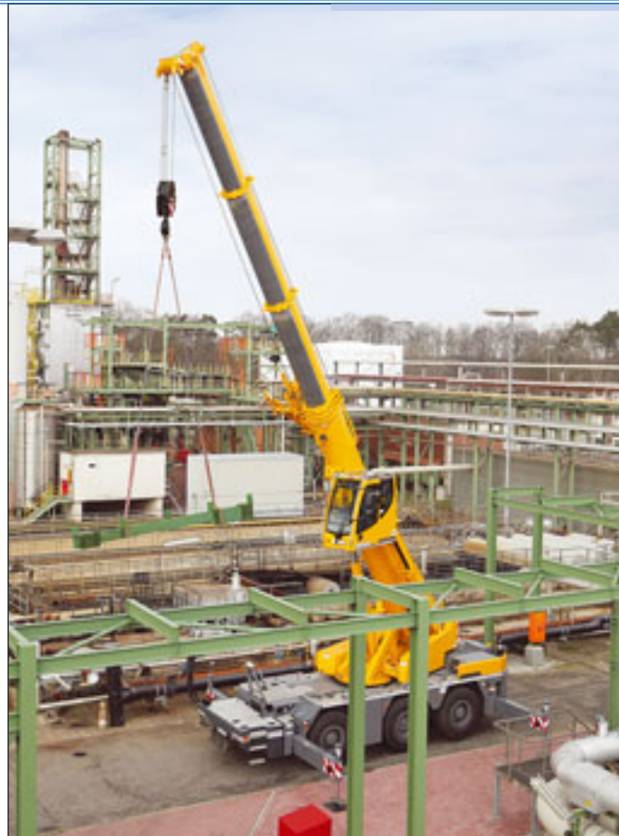
Der Liebherr LTC 1045-3.1 mit hochgefahrener Krankkabine
