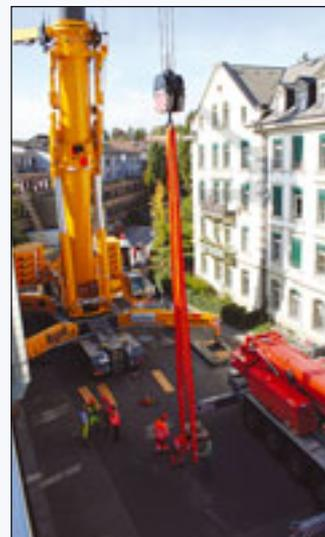
kritischen Standort über 400 Tonnen Gewicht. Der Auftrag erforderte eine hydraulische Kranauslegerlänge von über 94 Meter. Für den Auf- und Abbau des „Colossus“ wurden jeweils sechs Stunden benötigt.
