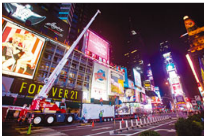
Ein AC40 von Terex im nächtlichen Einsatz am New Yorker Times Square. Ein Werbeschild der Bekleidungskette „Forever21“ musste an seinen neuen Platz eingehoben werden. Lasten bis zu 2,54 Tonnen bei einer Ausladung von 21,3 Meter galt es einzuheben
