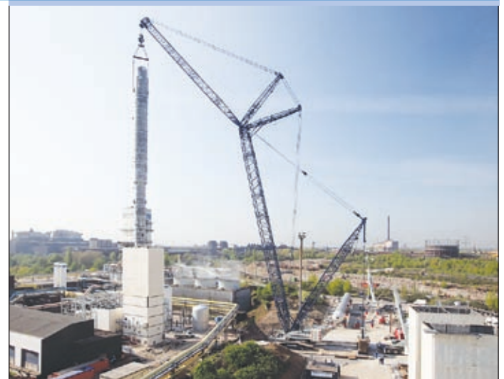
Breuer & Wasel baute in Duisburg für Linde Gas zwei Kolonnen ein: Mit einer 125 Tonnen schweren und 58 Meter langen Kolonne am Haken musste der LR 1600/2 seitlich schwenken und schließlich über mehrere Meter hinweg Richtung Montageort verfahren. Sie wurde von oben in ein 30 Meter hohes Gebäude abgelassen. Dazu musste der LR 1600/2 die große Last auf eine Hakenhöhe von 96 Metern bei einer Ausladung von 48 Metern heben.
