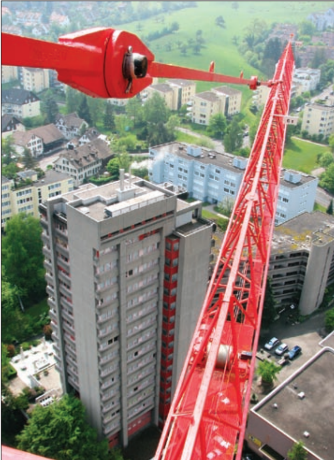
Montage eines Wolff 92 FL auf einem 60 Meter hohen Hochhaus in Leimbach bei Zürich. Der Kran wurde von Kaufmann Kranservice generalüberholt und umgebaut auf Frequenzumrichterantriebe
