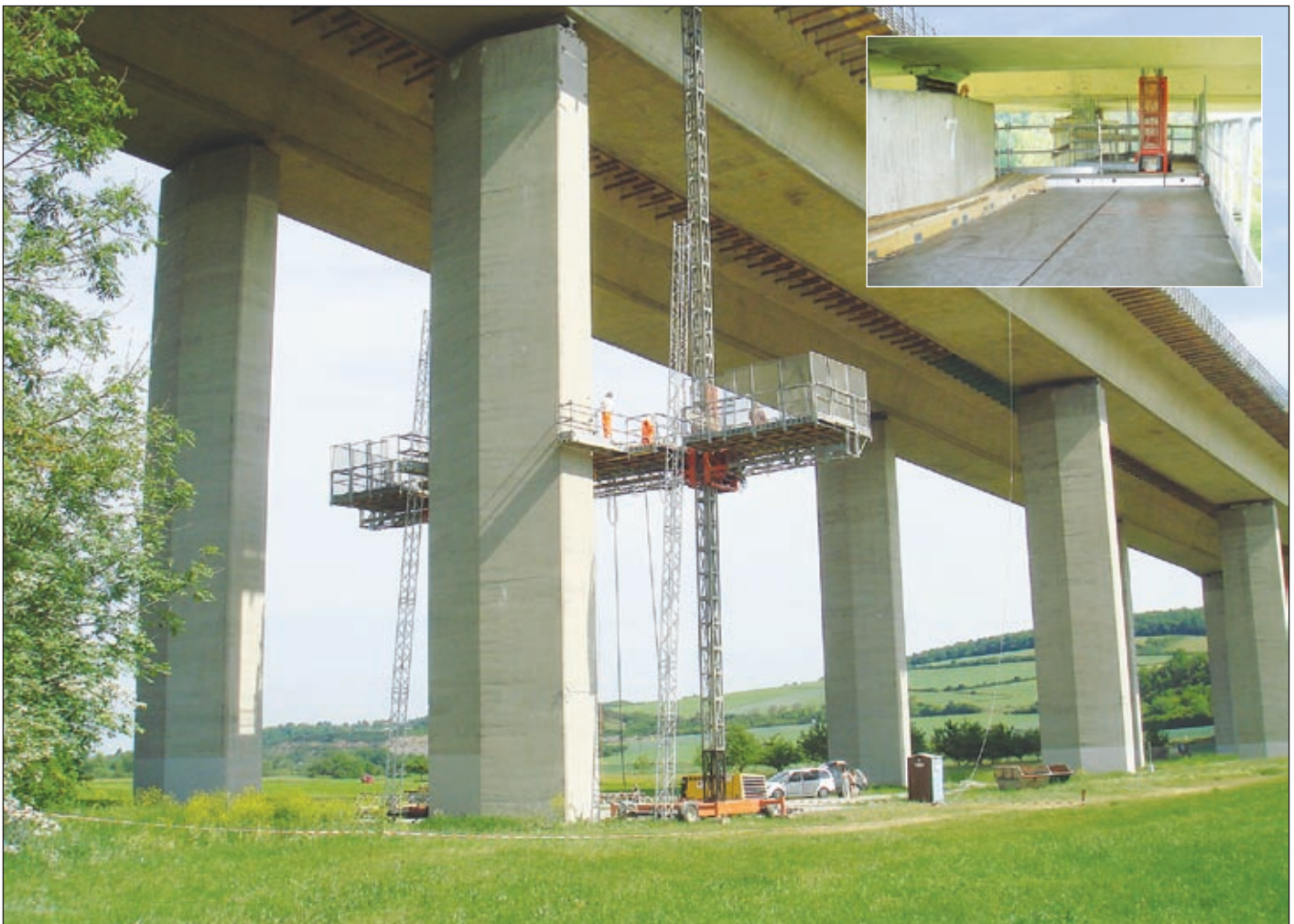
Die Taubertalbrücke bedurfte einer Komplettsanierung. Mit der Arbeitsplattform von Fraco ging es nicht nur nah ein die Brückenstützen heran, auch die Fahrbahnunterdecke konnte bequem erreicht werden
