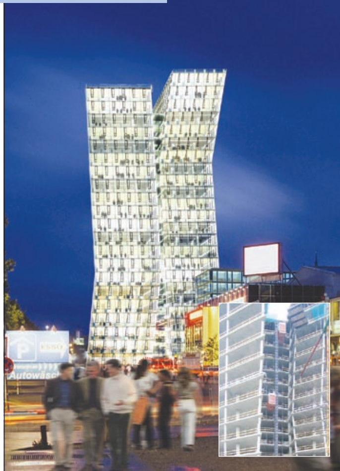
Auf der Reeperbahn schlängeln sich die „Tanzende Türme“ in die Höhe. Einen Mast teilen sich zwei Alimak Scando 650
