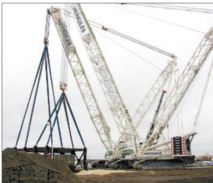
Zwei Terex Gittermast-Raupenkrane, ein CC 2800-1 und ein CC 2500-1, haben im Zuge des Umbaus der Autobahn S7 (Warschau-Danzig) einen historischen Bunker umgesetzt, der 464 Tonnen wog. Zur besseren Lastenverteilung wurde der Bunker in einen Käfig „gesperrt“.
