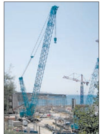
Der niederländische Schwerlastspezialist PVE hat zwei Kobelco-Maschinen bei einem Museumsneubau in Marseille im Einsatz, darunter den 550-Tonner SL6000
