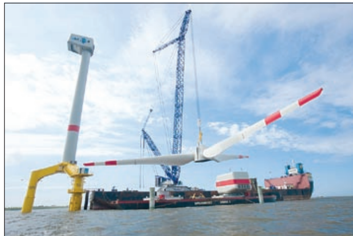
Maxikraft setzt einen Terex CC6800-1 auf Ponton ein
