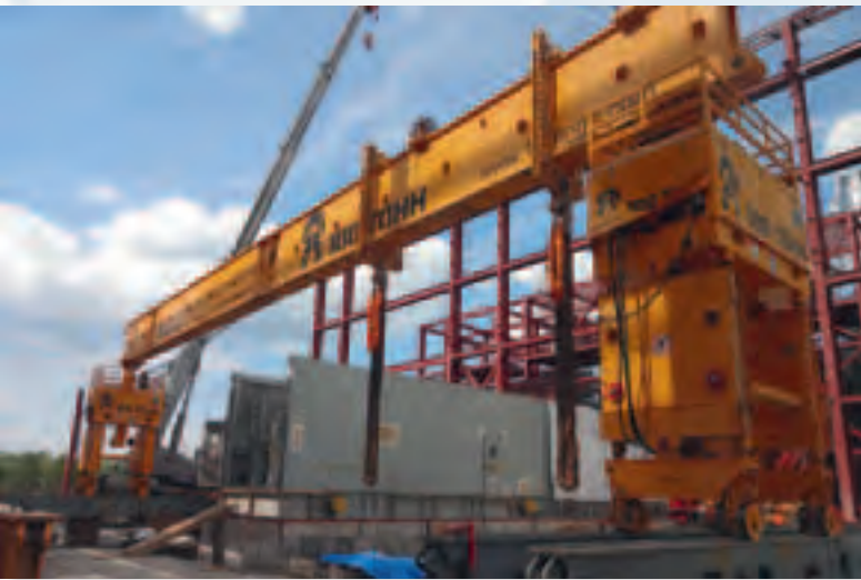
Einsatz in Sibirien: Das Unternehmen „100Tonns“ lud mittels einem Greiner GHS-3 250/500 vier Gasgeneratoren ab
