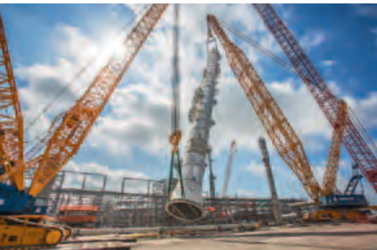
Sarens packt für seinen Terex CC 8800 seinen „Boom-Booster“ aus
