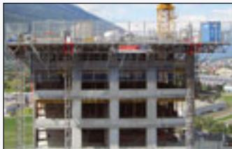
Die Fassade wird in weißem Metall, Beton und Glas ausgeführt; dafür arbeiten mehrere Mastkletterbühnen neben- und am selben Mast übereinander. Von den als Arbeitsbühne eingesetzten, die Gebäude umfassenden unteren HEK MSM Super werden die Fassaden eingemessen und deren Einzelteile montiert. Je nach Konfiguration bieten die MSM für diese Arbeiten je bis zu 80 Quadratmeter Arbeitsfläche beziehungsweise befördern bis 4.000 Kilogramm Nutzlast.
