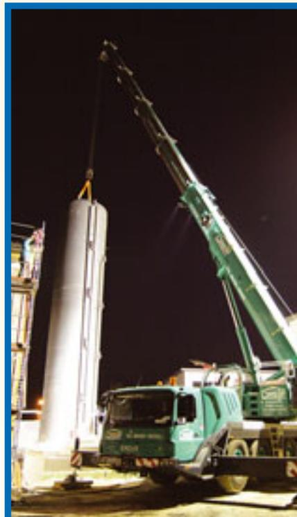
*Greif greift auf Grove zurück: Mit ihrem GMK4100 montiert die Firma Greif drei 23 Tonnen schwere Wärmespeichertanks am Hauptsitz der 3U Holding in Marburg. Der Betrieb führte die Arbeiten nachts durch, um nicht während der Geschäftszeiten zu stören.*
