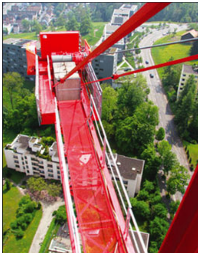
Kaufmann Kranservice montiert einen Wolff WK 92FL auf ein 60 Meter hohes Hochhaus in Leimbach bei Zürich
