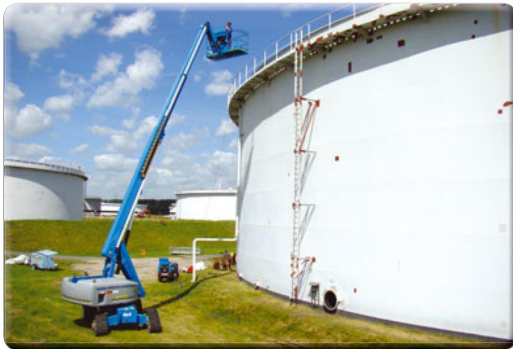
Mit Hilfe der Genie Trax S-65 von Ulferts & Wittrock erfolgten in Wilhelmshaven umfangreiche Beschichtungsarbeiten an vier Tanks, um diese gegen Wind und Wetter zu schützen
