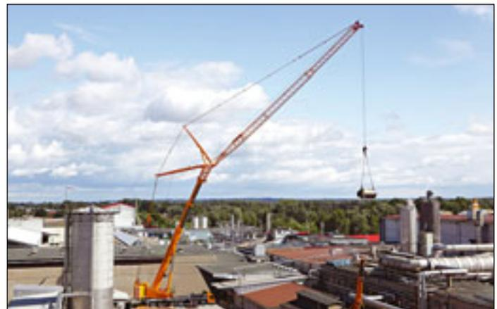
Reichweite war in der Papierfabrik gefragt: Der Liebherr LTM 1350-6.1 von Schmidbauer hatte einen 15 Tonnen schweren Trockenzylinder bei 46 Meter Ausladung am Haken
