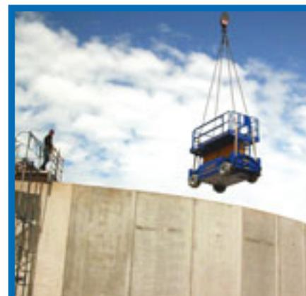
*Um an ihren Einsatzort gelangen zu können, wurde diese Schere kurzerhand per Kran ins Silo einer Biogasanlage in Brakel eingehoben, da das Silo bereits geschlossen war. Diese Bühne wurde speziell wegen der Tragfähigkeit von 600 Kilogramm vom Partnerlift-Mitglied Jörg Rauscher aus Lauenförde beim Kunden eingesetzt.*
