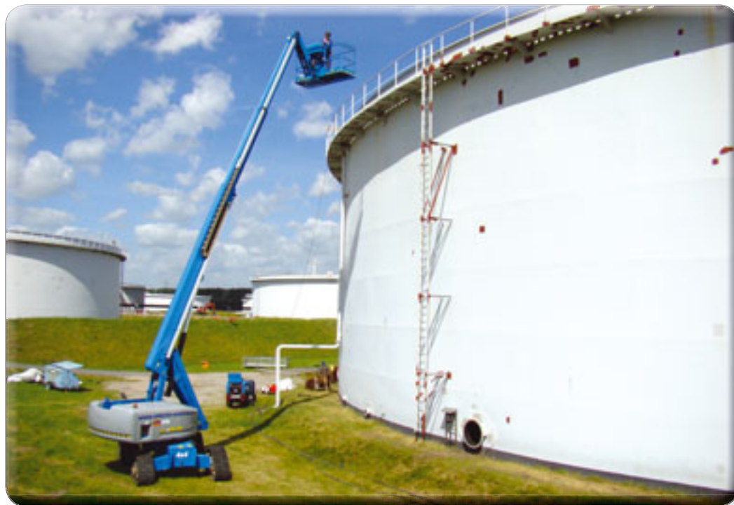
Mit Hilfe der Genie Trax S-65 von Ulferts & Wittrock erfolgten in Wilhelmshaven umfangreiche Beschichtungsarbeiten an vier Tanks, um diese gegen Wind und Wetter zu schützen
