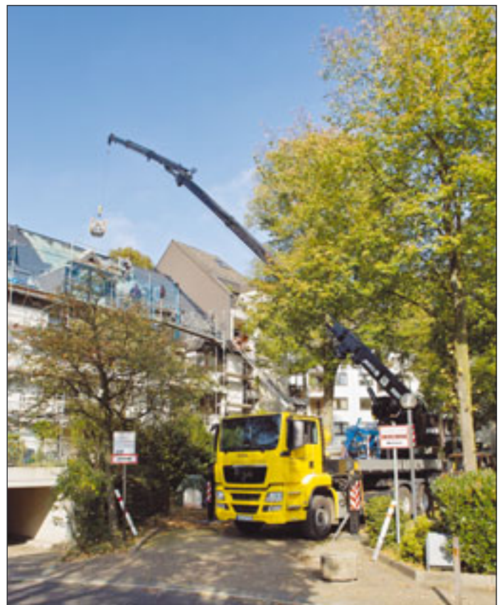
MKG-Kran im Einsatz
