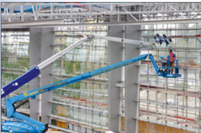
In Frage kamen nur 20-Meter-Gelenkteleskope mit Elektroantrieb
