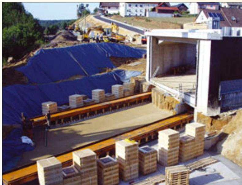
Wasserleitung nicht zu beschädigen. „Mit 1.450 Tonnen war es die bislang schwerste Brücke, die wir abgesenkt haben“, sagt Bausch. Um die Brücke in Neuhaus 1,60 Meter abzusenken, hat Konecranes das Bauwerk in elf Schritten zu je 14 Zentimetern
