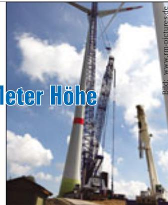
tiert werden und so die Basis des Gittermasts verstärken. Damit erreicht der Kran mit der Ausleger-Kombination SSL/LSL eine Höhe von 156 Metern zuzüglich der abgewinkelten Vorbauspitze mit Montagehaken. Außergewöhnlich war nur der erforderliche Superlift-Ballast beim Aufrichten: Der wurde in Breidenbach wegen der schweren Zusatz-Komponenten auf 450 Tonnen berechnet.
