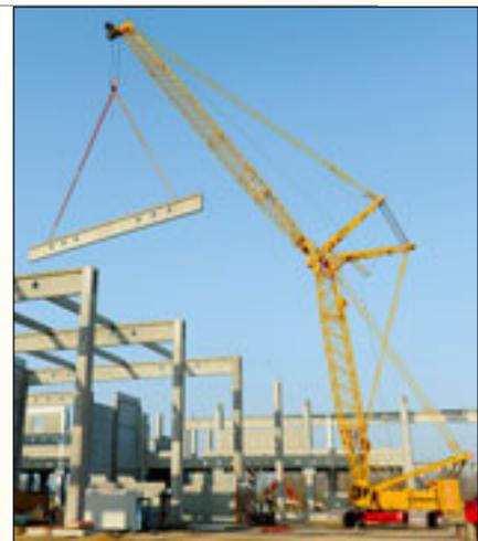
Maschine vom Montagewerk in Straubing direkt zur Baustelle liefern lassen. Insgesamt wurden beeindruckende 2.857 Standteile wie zum Beispiel Pfetten, Binder oder Unterzüge mit bis zu 42 Tonnen Gewicht verhoeben.
