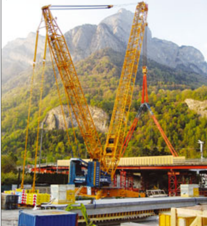
Die Gittermastraupen PC6800 von Sarens beim Brückentausch in Sargans
