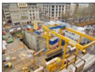
Hebezeuge fertigte einen 20-Tonnen-Portalkran, ein Unikat, zur Bedienung des Tunnels
