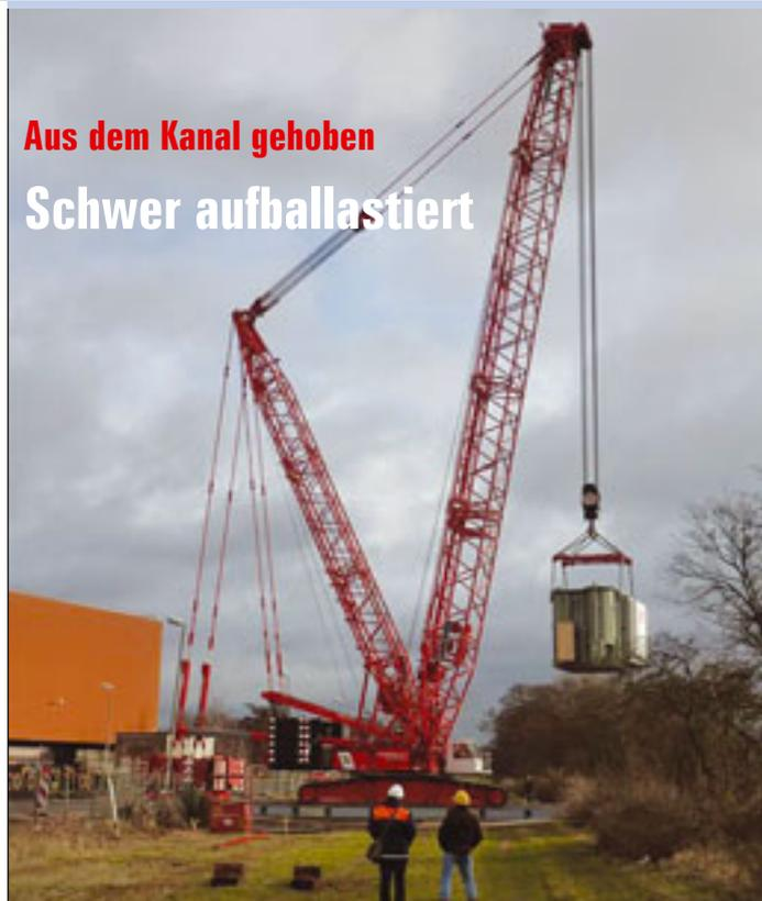
Ein 165 Tonnen schwerer Trafo musste in der niedersächsischen Stadt Peine vom Schiff auf einen Transporter umgeladen werden. Mit dem Spezial-Tiefklärer wurde der Riesentrafo dann zu seinem Bestimmungsort gebracht, dem Stahlwerk Peiner Träger. Mit seinen Maßen 5 x 8 x 5 Meter ist der Trafo alles andere als klein. Entsprechend musste der Liebherr LR1400 des Unternehmens
