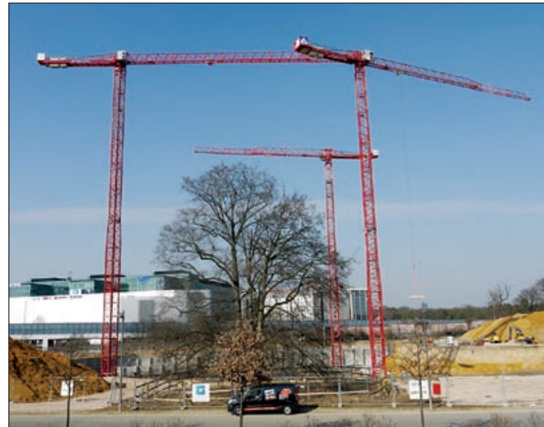
Am Frankfurter Flughafen entsteht der Stadtteil Gateway Garden. Damit der Flugbetrieb nicht beeinträchtigt wird, dürfen die Krane nicht über 180 Meter über Normalnull reichen. Hierbei kommen die spitzenlosen Modelle von Wilbert zum Tragen.
