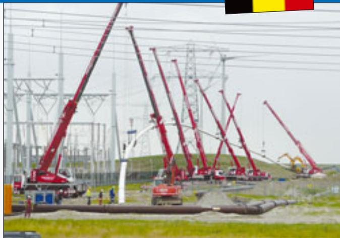
Acht Krane von Wagenborg Nedlift schultern die 400 Meter lange und 77 Tonnen schwere Pipeline
