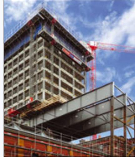
samt 17 Antriebseinheiten der Mastkletterbühnen-Typen Hek MSHF und Hek MSM Super nebeneinander. Nach Fertigstellung der Rohbauarbeiten wird die obere Mastkletterbühnen-Ebene per Turmdrehkran abgebaut und am Boden demontiert.
