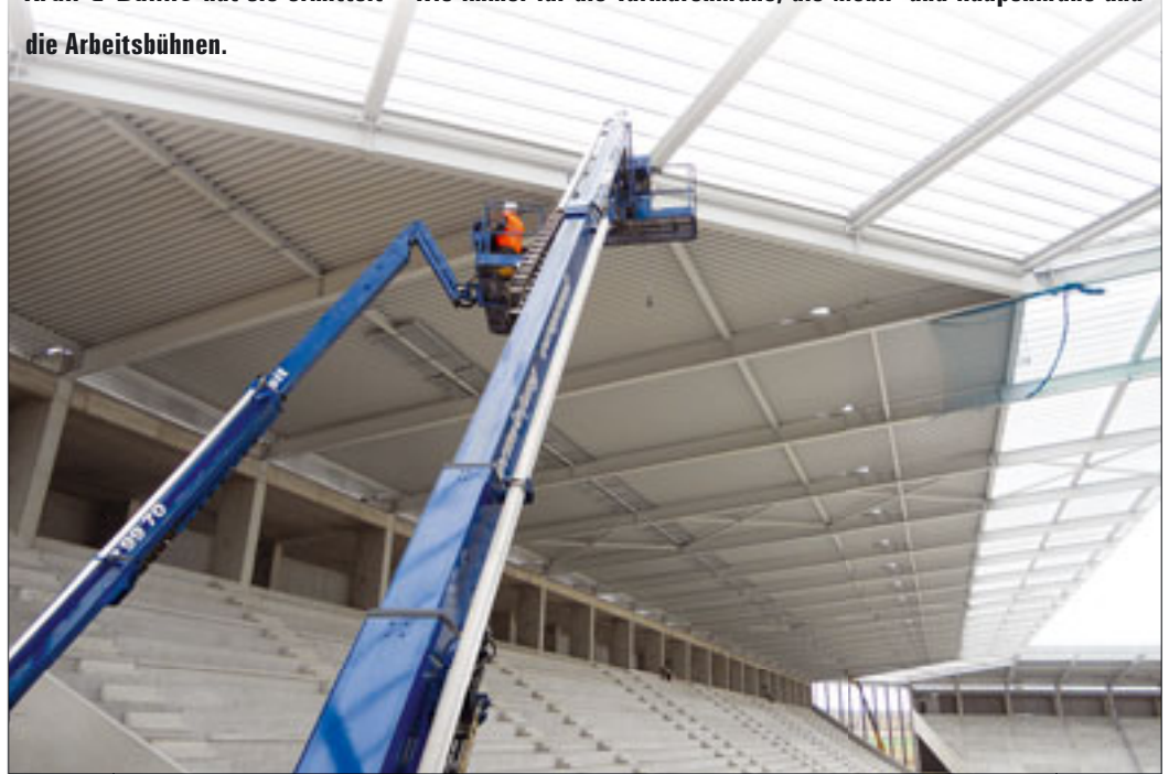
In der Fußballarena Mainz hat Beyer Mietservice zwei Diesel-Teleskopbühnen mit 34 und 40 Meter Arbeitshöhe bei Dacharbeiten eingesetzt
