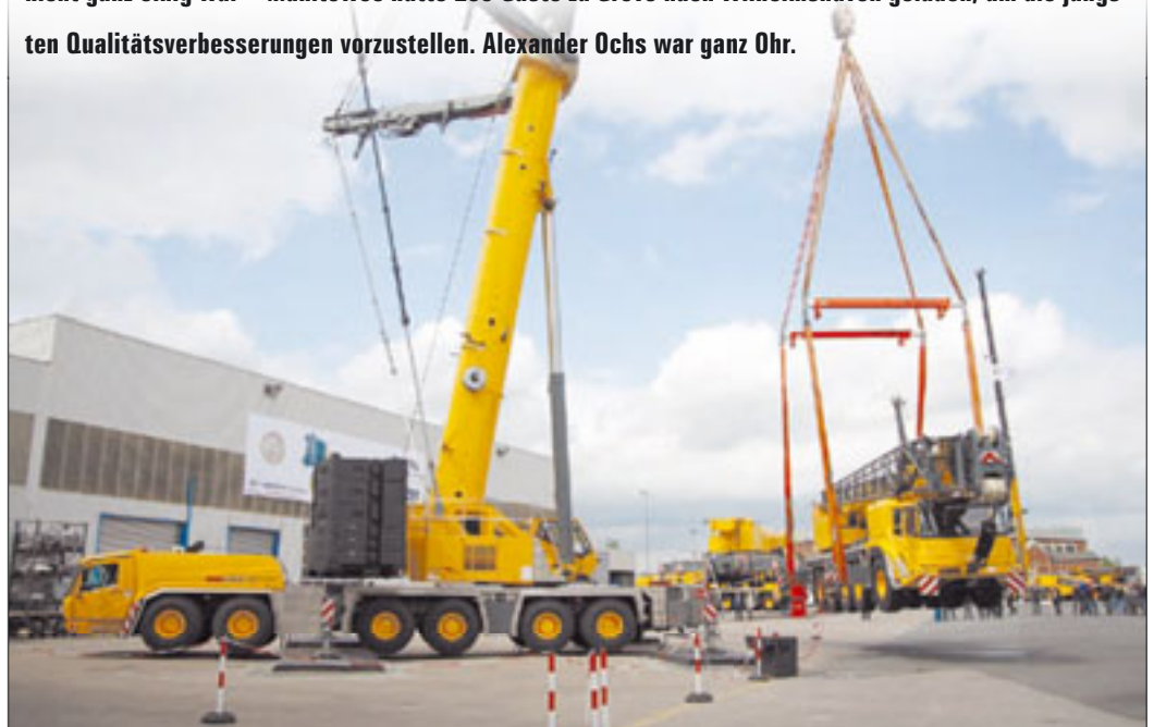
Ein GMK6400 hebt den 60 Tonnen schweren 5-Achser GMK5165-2
