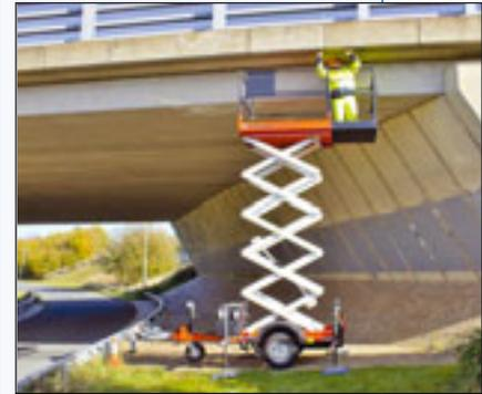
Schuler & Schuler aus Immensee hat sich mit einer kompakten Arbeitsbühne verstärkt: Frisch eingetroffen ist eine Anhängerbühne mit Radantrieb vom Typ Snorkel XT24 SD, welche die Besonderheit aufweist, dass es sich um einen Scherenaufbau handelt. Sie verfügt über eine selbstnivellierende Abstützung, die auch vom Korb aus bedient werden kann. Die Bühne kommt auf über neun Meter Arbeitshöhe und stemmt 227 Kilogramm Korblast.
