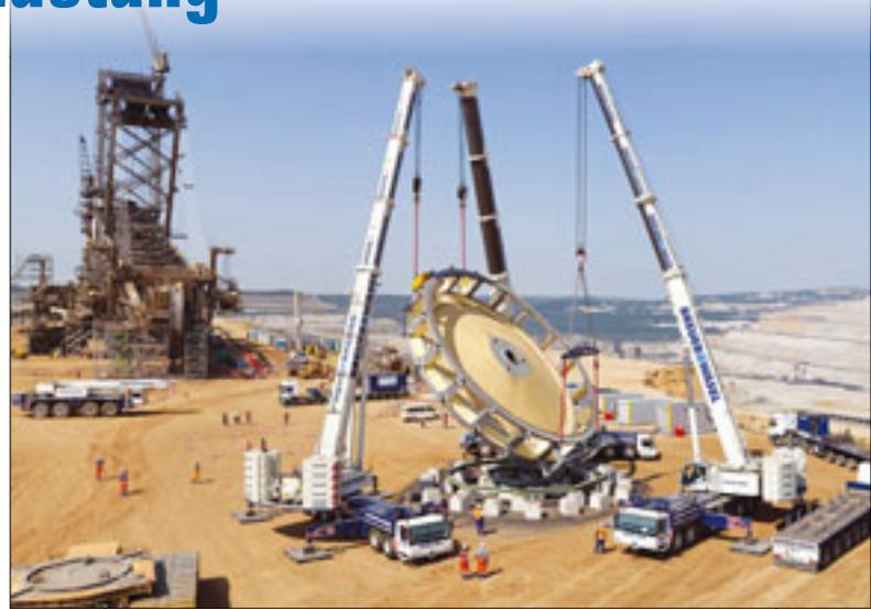
Last mussten eigens Anschlagmittel konstruiert werden. „Wir mussten zudem eine Sicherheitsanweisung des Auftraggebers beachten, wonach bei Tandemliftarbeiten die Krane zu höchstens 80 Prozent ausgelastet sein dürfen“, erklärt Jürgen Oprée,
