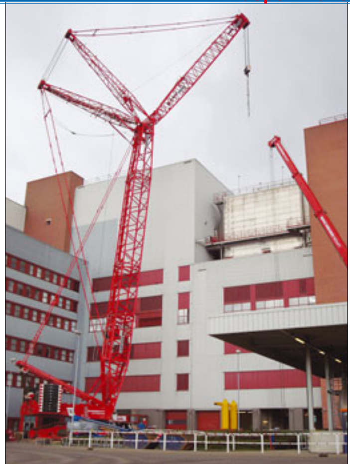
Wagenborg Nedlift setzte beim Kesselaustausch in Moerdijk auf seinen 750-Tonner LR1750
