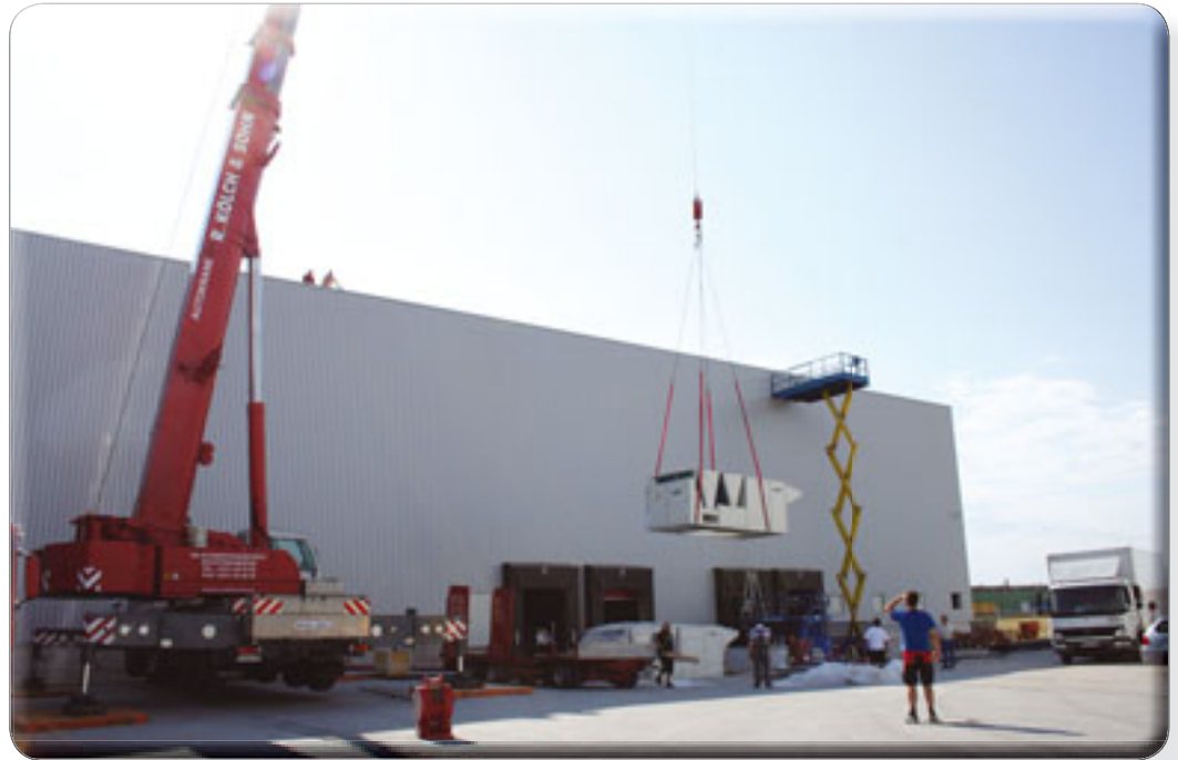
Die Crew der R. Kölch & Sohn GmbH im Einsatz: Mit dem ATF 220G-5 aus dem Hause Tadano Faun werden bei 73 Meter Ausladung zwei 2,3 Tonnen schwere Industrieklimageräte auf ein 15 Meter hohes Hallendach gehoben
