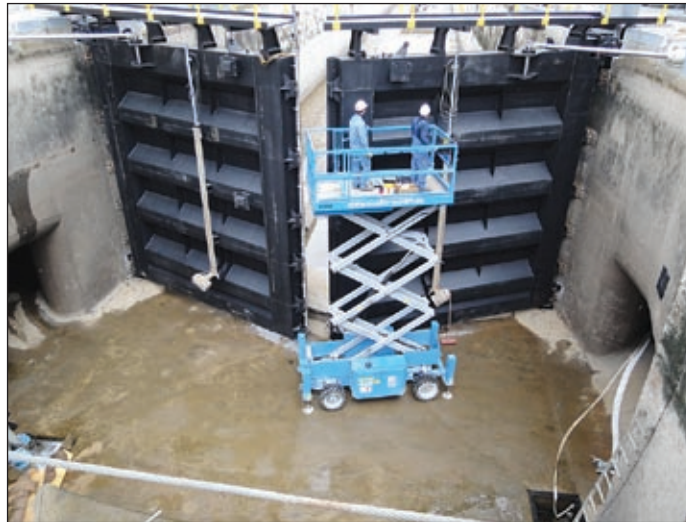
Eingeschleust: eine GS-2669RT im Schleusentor-Einsatz am Main
