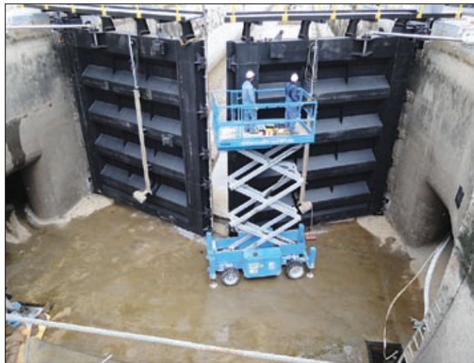
Eingeschleust: eine GS-2669RT im Schleusentor-Einsatz am Main
