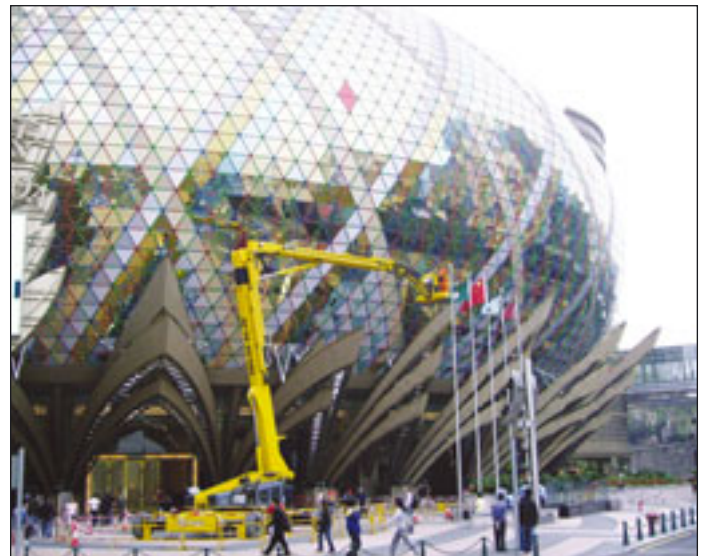
Platform Baskets SEL 48 ALJE im Einsatz
