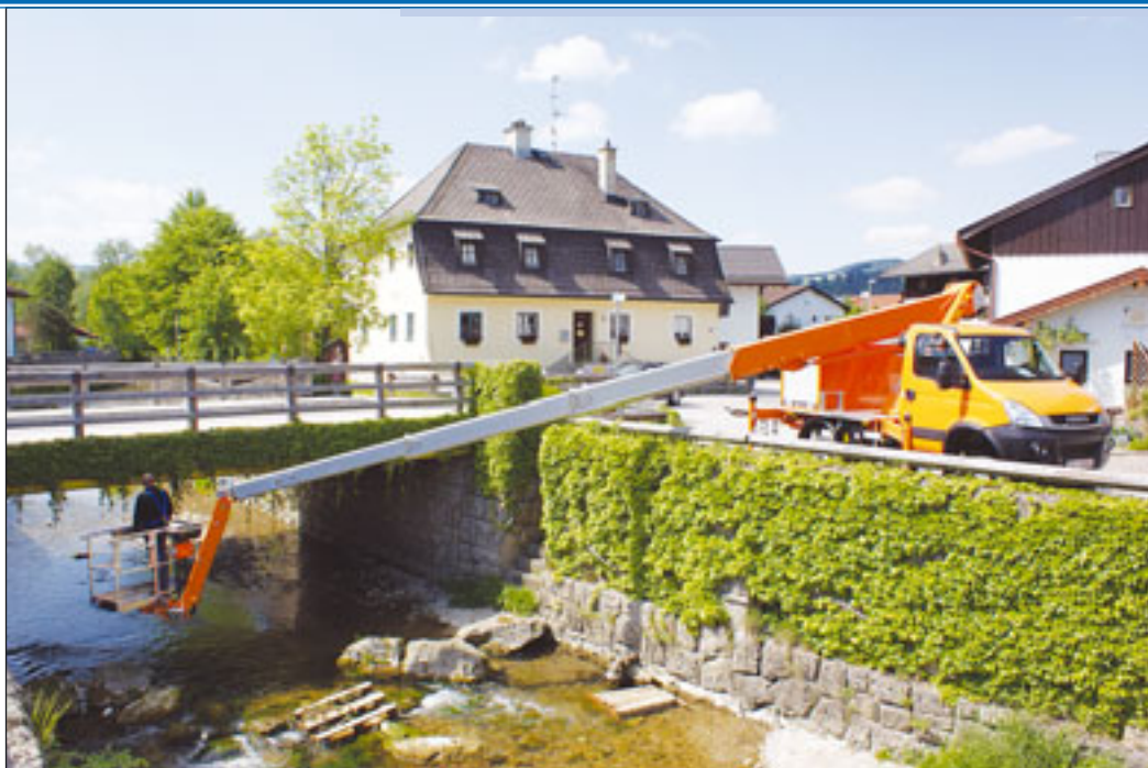
Unterflurarbeiten sind auch mit der P 210 BK von Palfinger möglich
