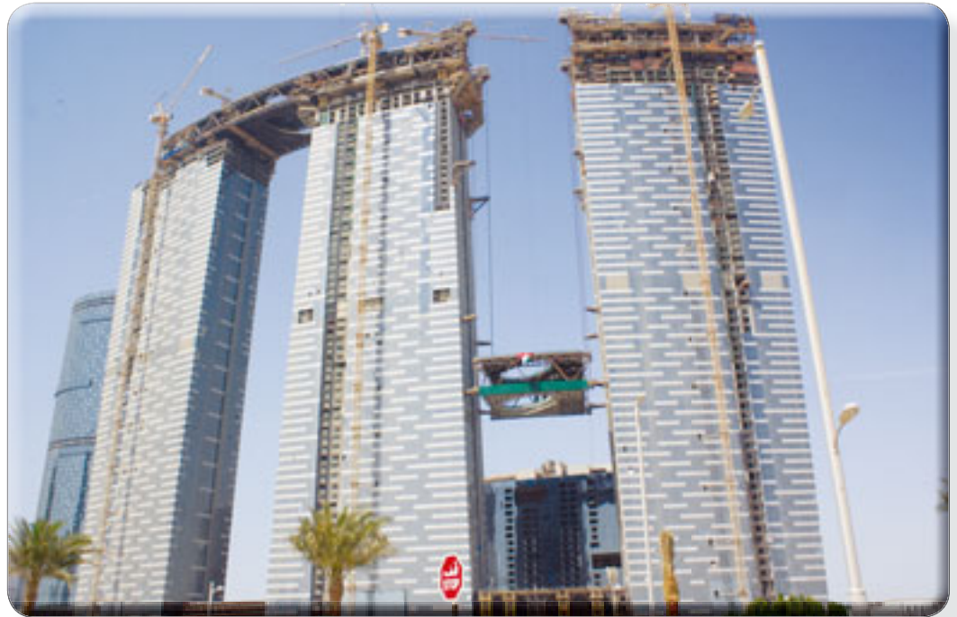
Zwei Hohlkastenträger und zwei Segmente mit einem Gewicht von 160 bis 750 Tonnen hievt VSL per Litzenheber auf 245 Meter Höhe
